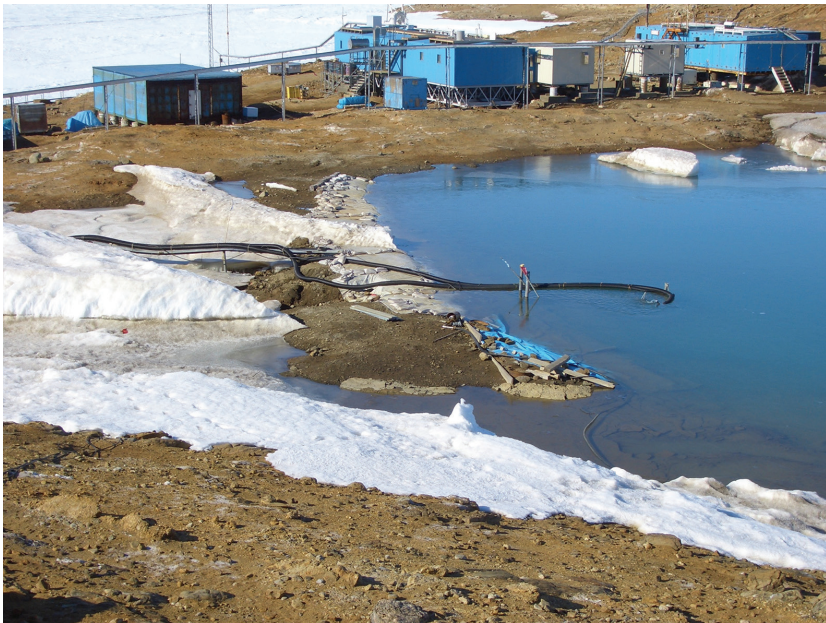
図 9 荒金ダムの堤防 (第 48 次隊撮影) Fig. 9. Dam wall at Aragane Dam (photograph by the 48th JARE).
