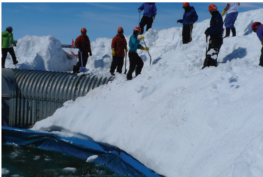
図 13 130kl 水槽への雪入れ (2012年7月27日撮影) Fig. 13. Snow casting into the 130kl water tank (July 27, 2012).
