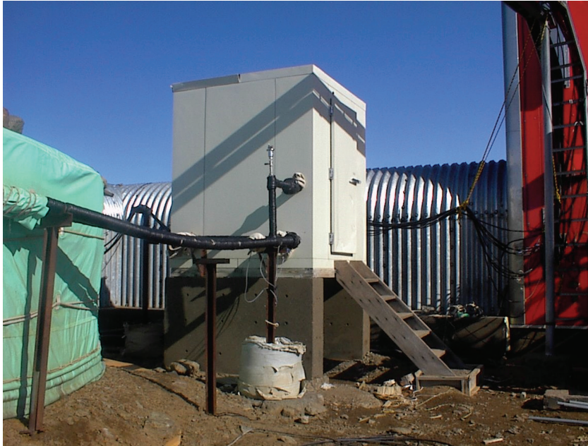
図 17 第 32 次隊で建設した熱交換器小屋
