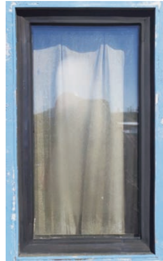
図 3 観測棟の開口部
