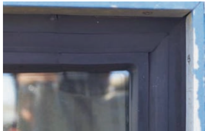
図 12 観測棟の構造ガスケットの表面。
