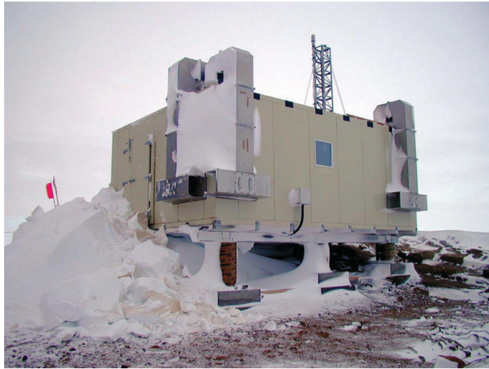
図 11 2004年5月30日のエアロゾル小屋における風下側ドリフト Fig. 11. Snow drift at the hut on May 30, 2004.
