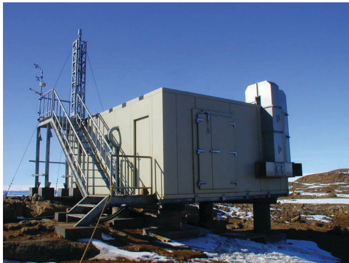
図 3 完成したエアロゾル小屋 Fig. 3. Aerosol observation hut
