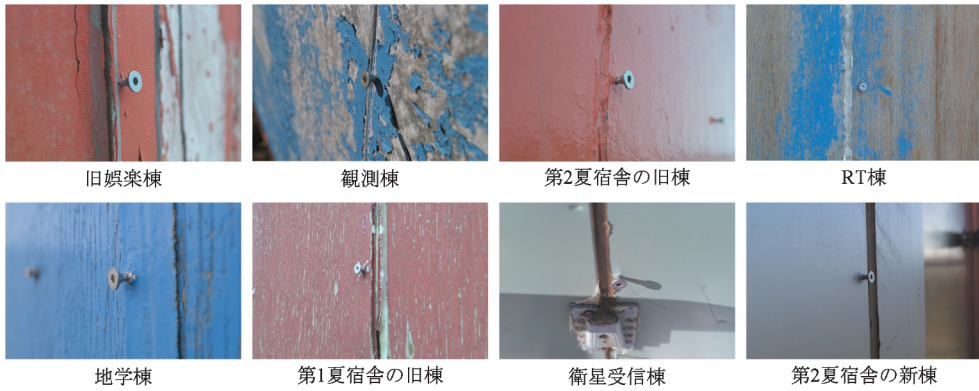
図 4 建物外壁面にねじ込んだビス
