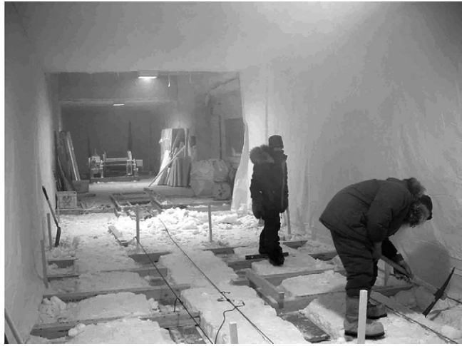
図8 新掘削場床の基礎の造成 (7月1日)
