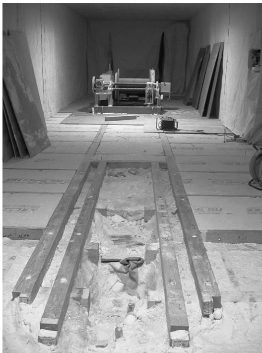
図 11 ウインチとマストとをつなぐ基礎材の構造（6月20日） Fig. 11. Structure of timbers which connect the winch and the mast (June 20, 2003).
