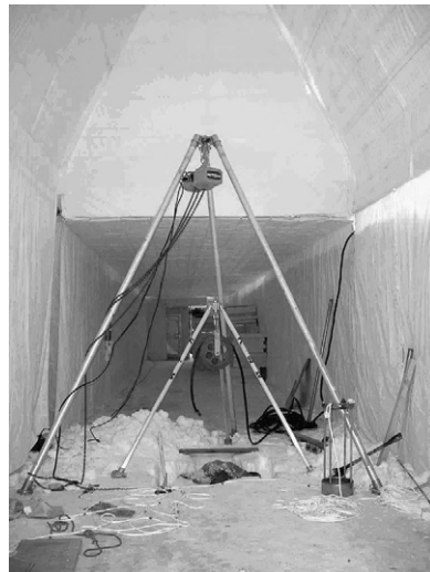
図2 ケーシングパイプ引き上げ作業(スチームパイプ保持用小型三脚とケーシングパイプ引き上げ用大型三脚, 3月7日)
