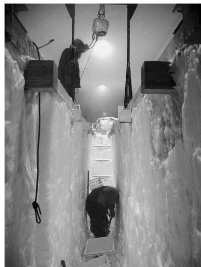
図 12 10 m ピット掘削の状況 (8 月 19 日) Fig. 12. Constructing a 10-m deep pit (August 19, 2003).
