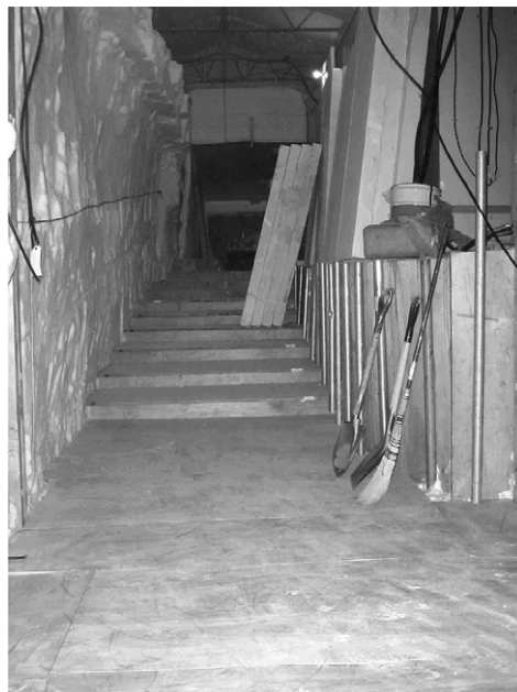
図15 造成した階段(9月4日)
