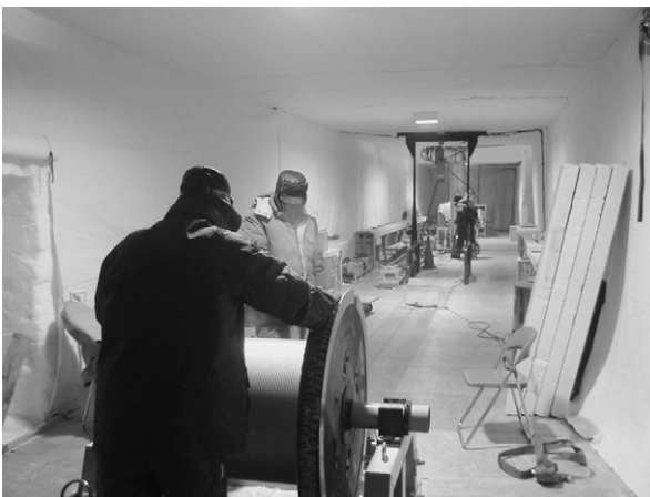
図22 ケーブル巻き取り作業(11月18日)
