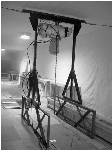
図 18 小型門型クレーンのかさ上げ部 (10月1日) Fig. 18. Raised part of the small goliath crane (October 1, 2003).
