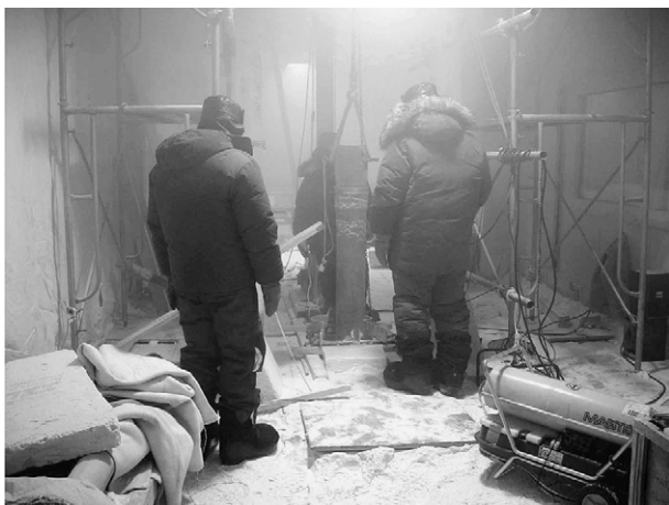
図6 ケーシングパイプ挿入作業 (5月1日)
