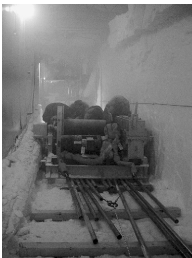
図7 ウインチ移設作業の様子 (5月30日) (4人でウインチを押す。手前には差し込んだ単管パイプ)
