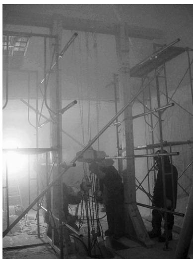
図 3 ケーシングパイプ引き上げ作業（柱を転用した門型クレーンを使って実施、4 月 4 日）
