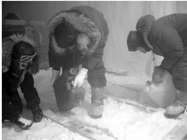
図9 水セメントによる床基礎材の固定 (6月7日)
