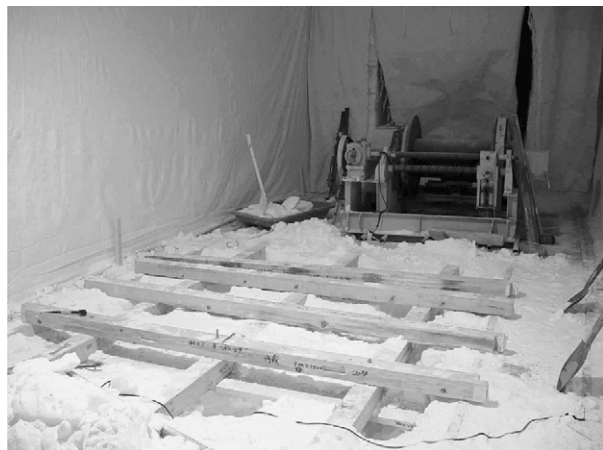
図10 新掘削場に設置したウインチ基礎 (6月6日)
