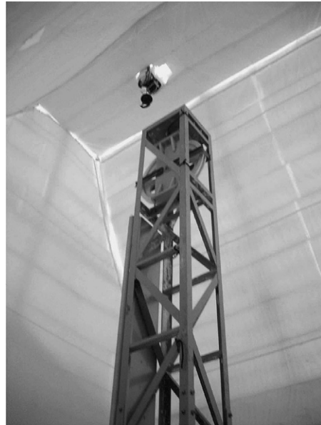
図 20 新掘削場高屋根部に設置したチップ回収用吊り下げウインチ (11月10日)
