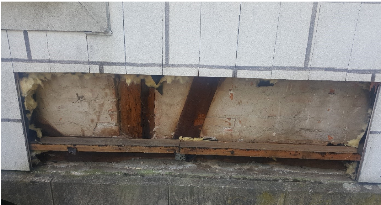
Abbildung 4.11: Fachwerk hinter der geöffneten Fassade.
