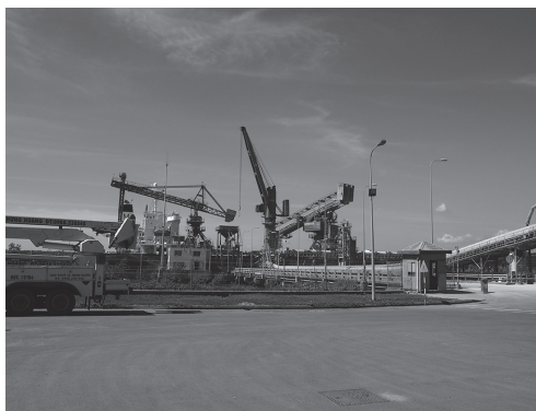
写真1 カイメップ港での荷揚げ設備
