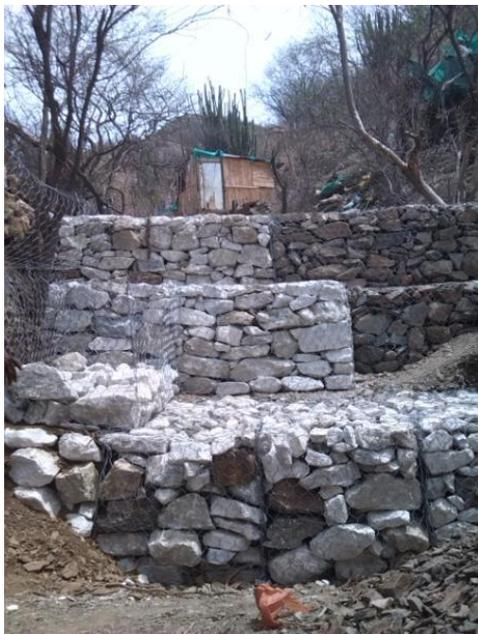
Fotografía 11: Colocación de capas de piedra
