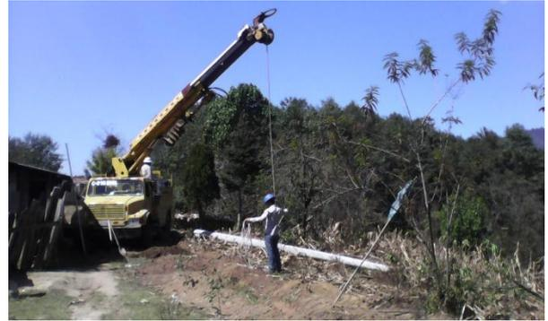
Fotografía 2: Instalación de postes del tendido eléctrico de media tensión lote 1.2
