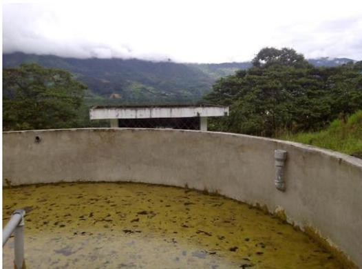
Fotografía 1: Filtro lento de arena en desuso con caseta de cloración en segundo plano sistema San Pedro (Zamora-Chinchiipe)
