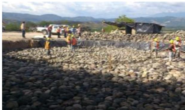
Fotografía 4: Trabajos de Cimentación para tanque de 150,000 Galones para Macro Red de Ojo de Agua.
