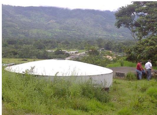
Fotografía 2: Tanque de reserva en desuso (en primer plano), tanque antiguo en uso con agua no tratada en segundo plano. Al fondo la comunidad de Leónidas Proaño (Zamora-Chinchiipe)
