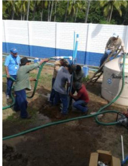
Fotografía 2: Instalación de punteras extractoras de agua para el proyecto en isla de Madresal.
