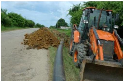
Fotografía 1: Colocación conductora con equipos de construcción del proyecto en La Palma
