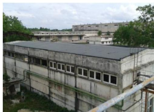
Fotografía 4: Rehabilitación zona químicos Jatibonico (impermeabilización y carpintería)
