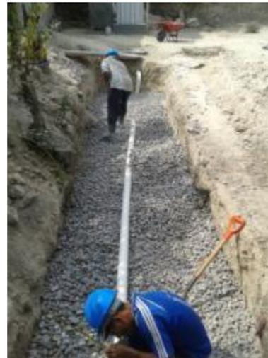
Fotografía8: Construcción de zanja de infiltración de aguas residuales en Ajuluco.
