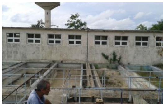
Fotografía 4: Filtros de arena y galería de control de filtros Jatibonico en rehabilitación
