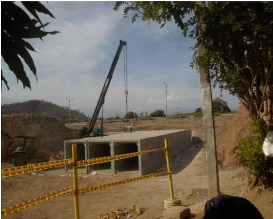
Fotografía 3: Colocación de Box Colver
