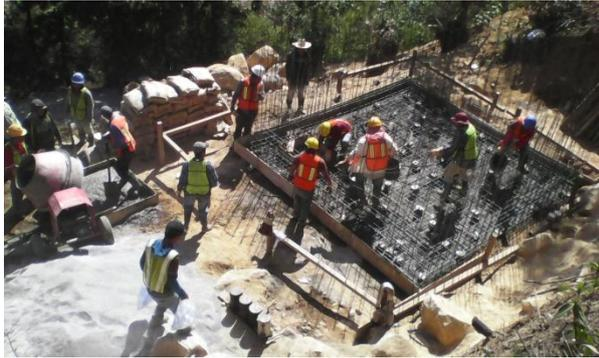
Fotografía 1: Foto Fundición de losa inferior (piso) del tanque de distribución lote 1.2
