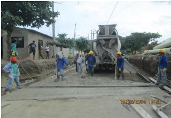
Fotografía 7: Vaciado de losa - pavimento
