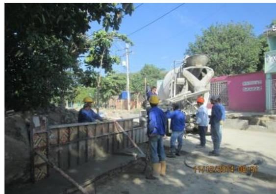
Fotografía 6: Colocación de formaletas para muros
