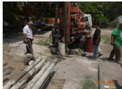
Fotografía 4: Trabajos de perforación de la construcción del pozo del proyecto de San Luís Talpa.
