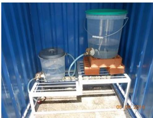
Fotografía 3: Dosificador de cloro desinfectante en el tanque de Puka Mayu, Cochabamba.
