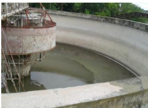
Fotografía 3: Decantador de PTAP de Jatibonico vaciado para rehabilitar.
