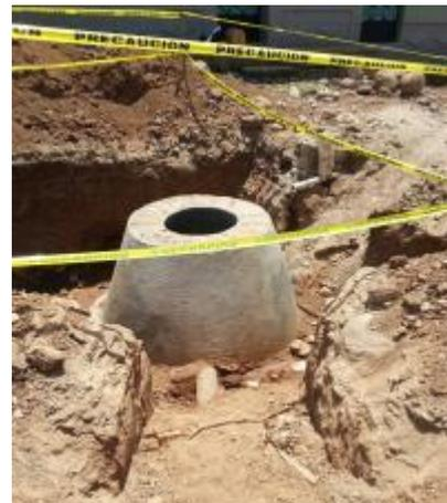
Fotografía 4: Construcción Alcantarillado Sanitario San Juan.
