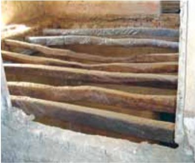
Vigas deformadas, por lesiones mecánicas
