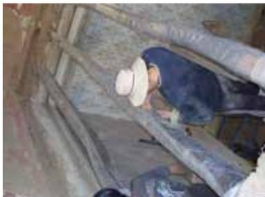
Tratamiento de un producto antixilofagos, mediante la técnica de imprimación y penetración profunda
