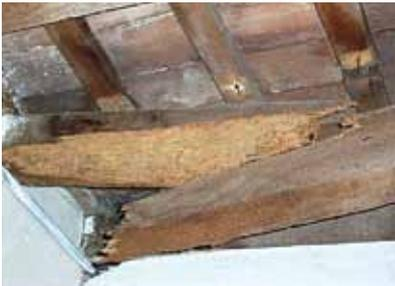
Ruptura de una viga, por sobrepeso
