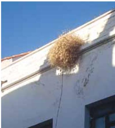
Biodeterioro, causado por humedad
