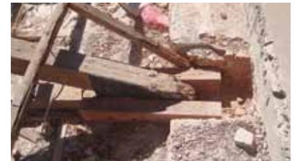
Prótesis para aumento lateral de sección de viga y sustitución de cabeza de viga
