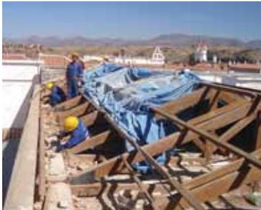
Refuerzo y nivelación de estructura original de madera
