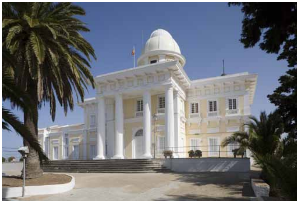
Edificio principal del Real Observatorio de la Armada en San Fernando
