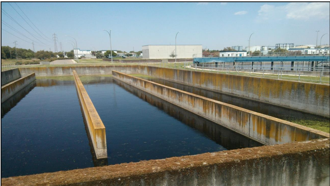
Figura II.20. Muestras tomadas en la EDAR Copero (salida de proceso secundario igual a la salida de depuradora)
