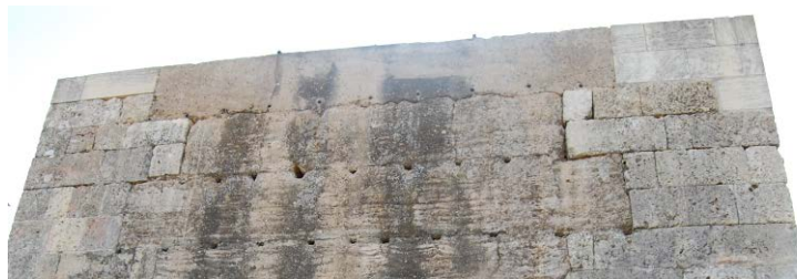
Fig. 3. Área restituida de tapia en la Torre de Don Fadrique (Créd. Los autores)
