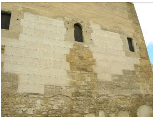
Fig. 5. Reparación de tapia a una cara en el Alcázar de la Pta. de Sevilla, Carmona (Créd. los autores)
