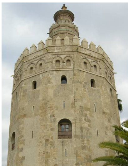
Fig. 8. Vista de la Torre del Oro después de la intervención de 2004 (créd. los autores).
