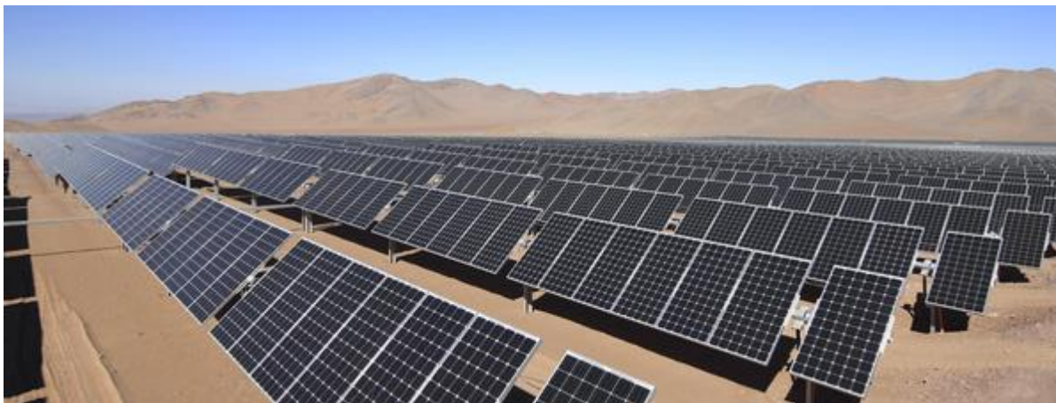
Ilustración 3.4. Fotografía de una planta fotovoltaica: Amanecer Solar CAP, 100 MW (Chile).
