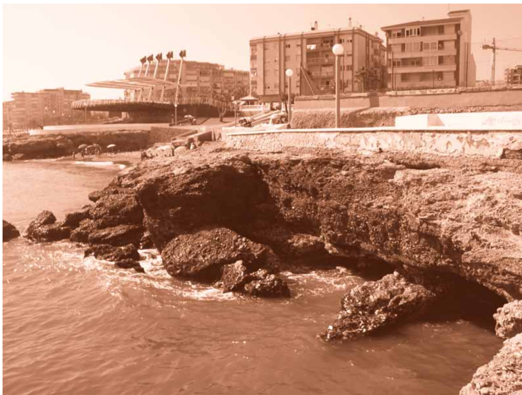
Figura 10. Detalle del extremo meridional del espigón sobre el que se sitúa la uilla del Faro de Torrox-costa, que parece corresponder a sendas grutas artificiales, parcialmente destruidas en la actualidad. Al fondo, en la parte izquierda, se ve el segundo espigón sobre el que se sitúa la factoría de salazones altoimperial y la necrópolis tardía
