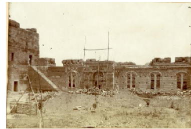
Fig.215 Colocación de andamiajes para la construcción del pabellón del museo. Circa: 1905 (AGA 8871)
