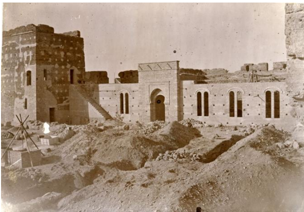
Fig.39 Vista de las trincheras realizadas en las obras del Castillo de Mairena del Alcor (AGA 8868).
