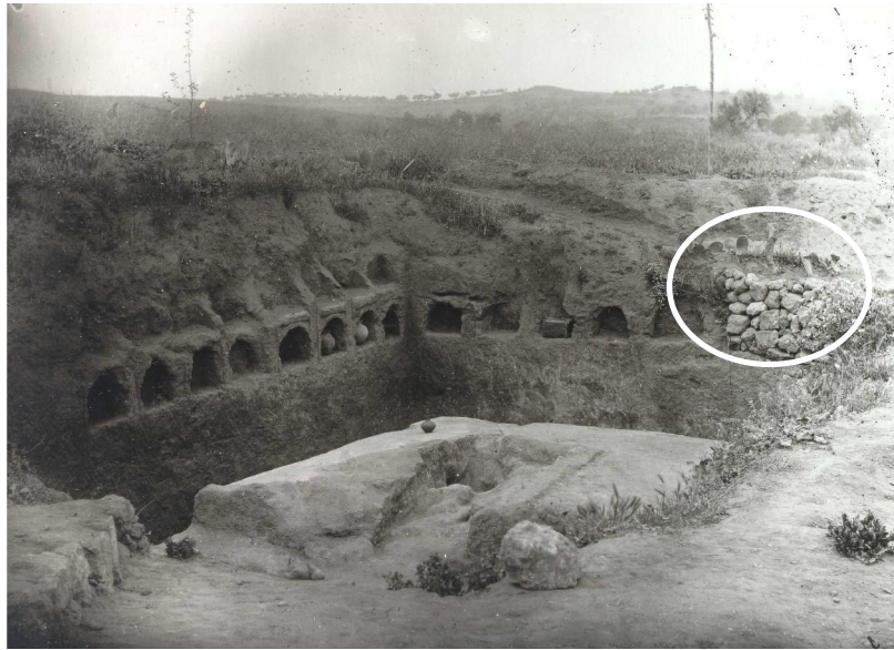
Fig. 83 Detalle de la colocación de taludes realizados con mampostería en el Columbario Triclinio (AGA 7647)
