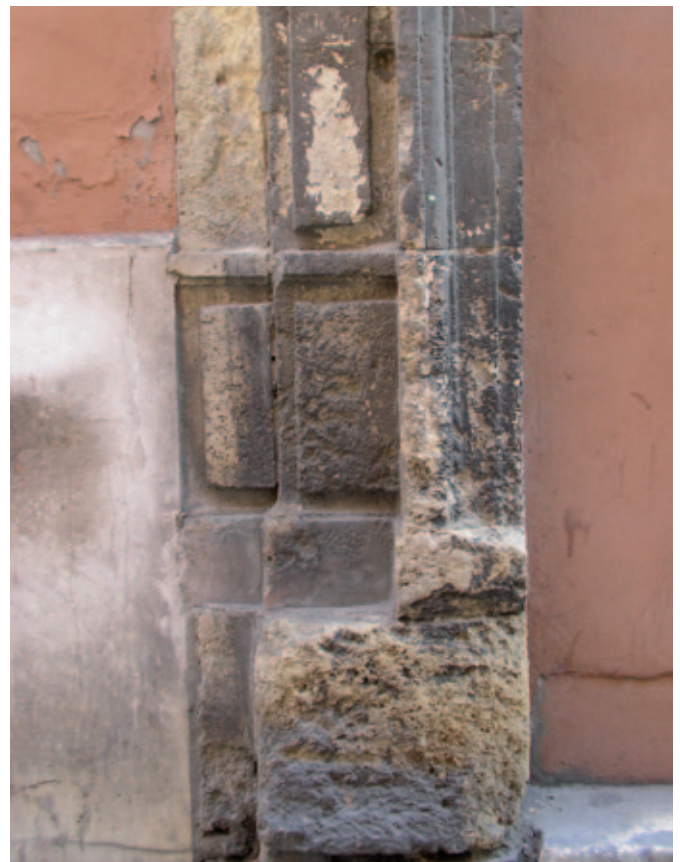
Costras negras en el basamento de la pilastra izquierda de la portada lateral de la iglesia de San José. Debajo, detalle del grado de disgregación y arenización de la roca. Fotos: P. Ortiz, M. S. Abad
