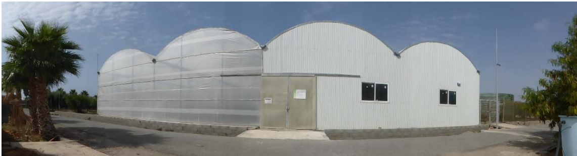
Fotografía 1. Frontal del invernadero multitúnel usado en la realización del ensayo.
