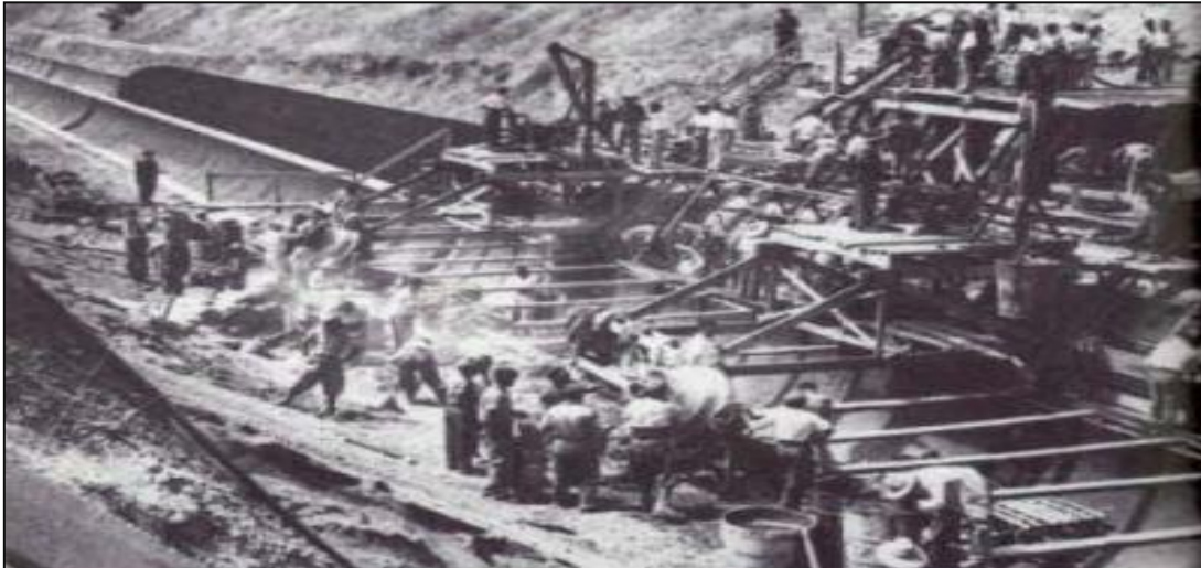
Figura 12.7. Obras de construcción de infraestructuras hidráulicas.
