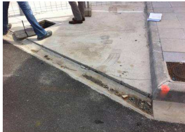
Fig 2 “Fracturación de piedras por esfuerzos excesivos” y Fig 3 “Hundimiento”.
