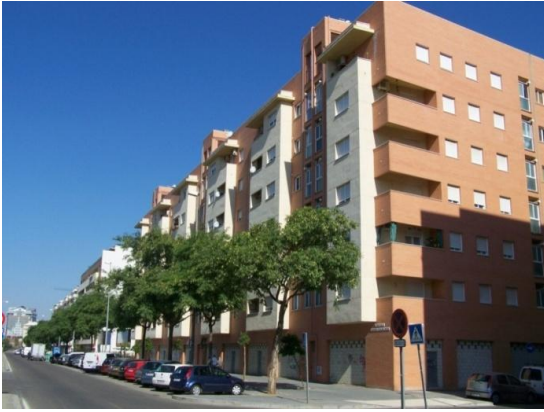
Fig. 1. Vista de la fachada oeste
