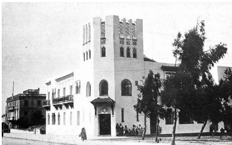
Fig. 115. Larache. Edificio de Correos y Telégrafos. África. Revista de Tropas Coloniales . Julio 1928.
