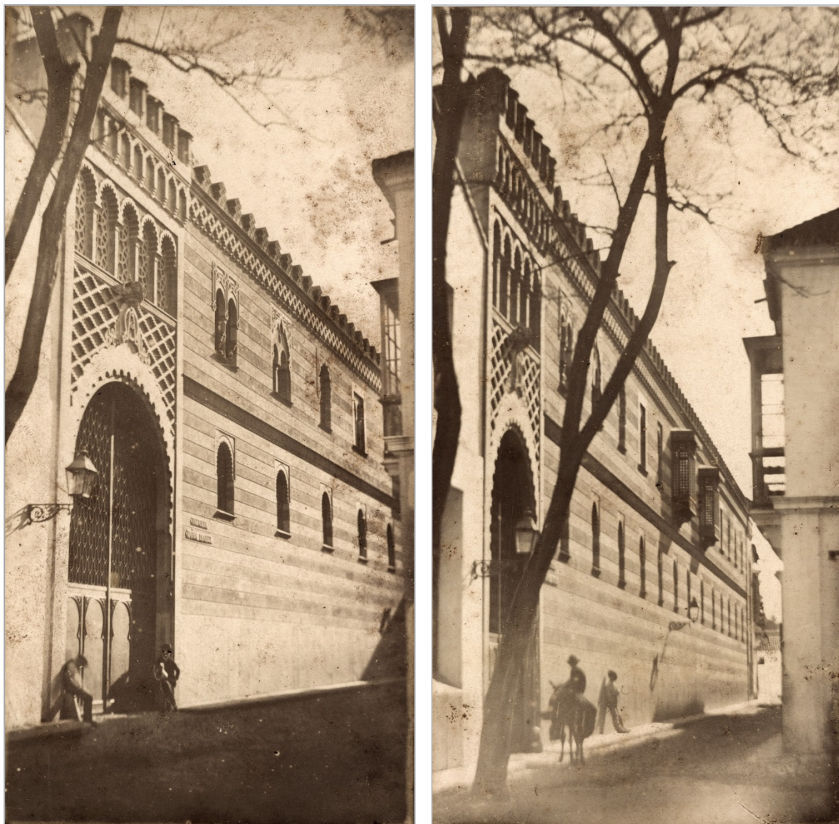
J. Díaz Duarte, Fachada de las Caballerizas del Palacio Orleans Borbón en la Calle Baños, ca. 1890, fotografías. Colección Infantes Duques de Montpensier.
