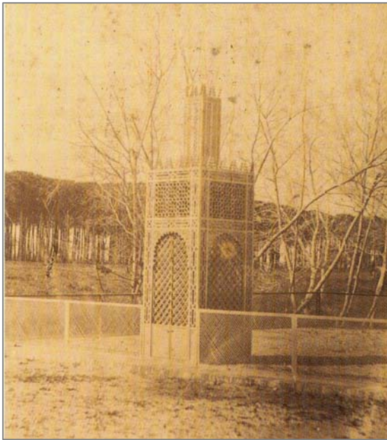
Díaz Duarte. Aspecto exterior del depósito de aguas del Pozo Nuevo y su pabellón a modo de minarete, en el Botánico. Ca. 1880-90. Fotografía. Colección descendientes de los Duques de Montpensier. Sanlúcar de Barrameda.
