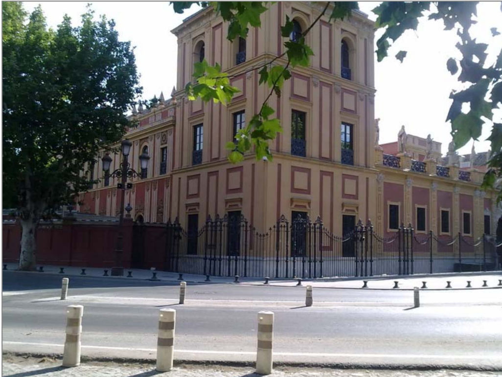
Fotografía, la Torre Nueva del Palacio de San Telmo , estado actual del sector Norte del Palacio.
