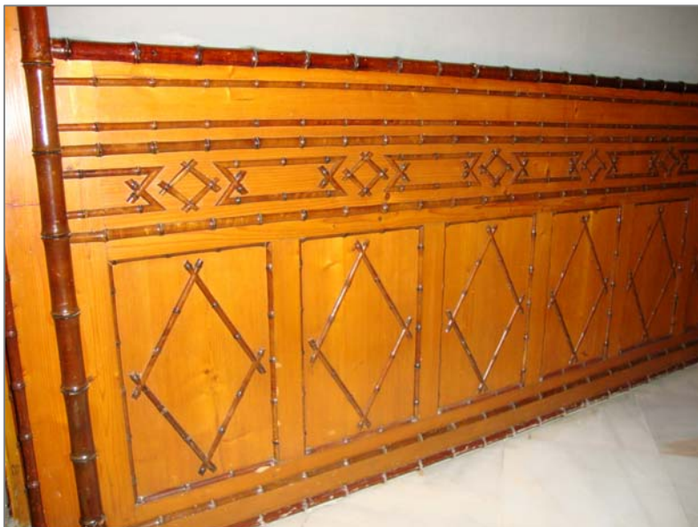
Detalle del zócalo en madera de pino barnizado y cañas de Bambú. Dormitorio de Bambú del Palacio de los Duques de Montpensier en Sanlúcar de Barrameda.
