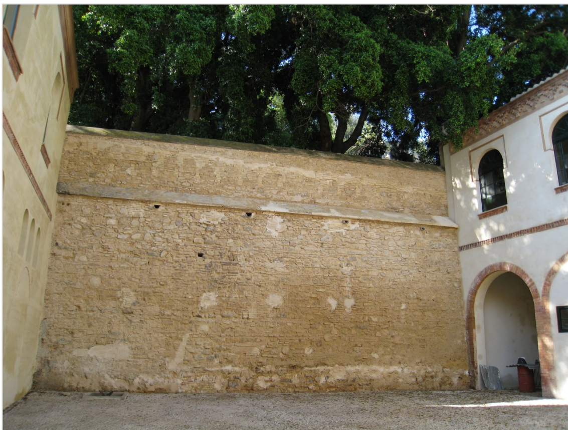
Vista del Patio de servicio, con la tapia de separación que salva el desnivel entre los jardines y las caballerizas. Fotografía actual.
