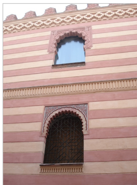
Aspecto exterior de la fachada del edificio de Caballerizas, detalle de dos vanos. Fotografía actual.
