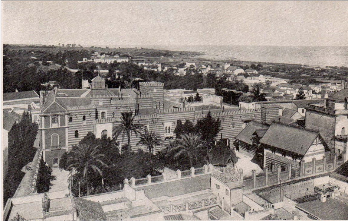
Fotografía. Palacio de los Duques de Montpensier en Sanlúcar de Barrameda . Portfolio fotográfico de España, ca. 1940. Colección del autor.
