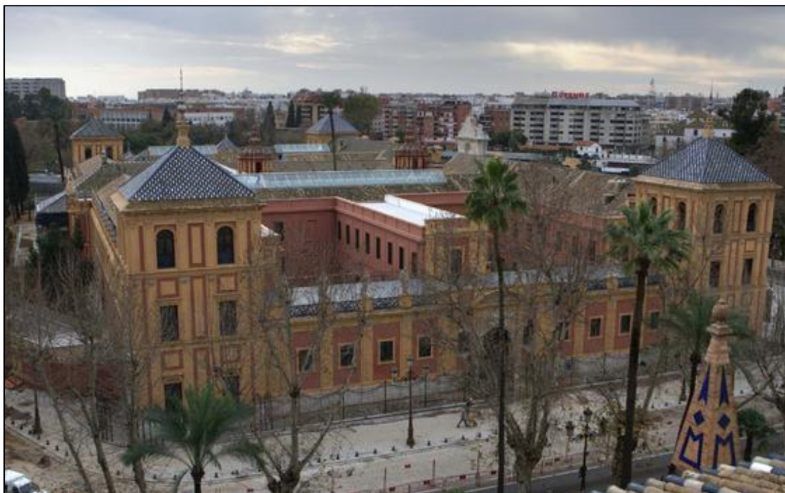
Estado actual del sector Norte del Palacio de San Telmo, con el antiguo patio apeadero, segmentado posteriormente en dos, fotografía.
