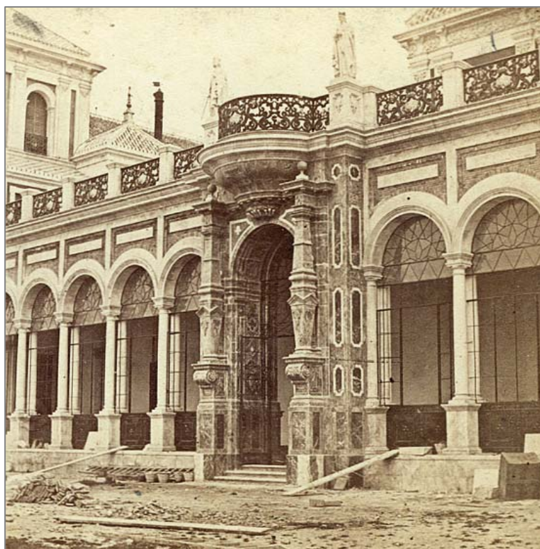
A. Gaudin, Galería nueva de San Telmo en construcción, original estereoscópico y albúmina, ca. 1857, Colección Fernández Rivero.
