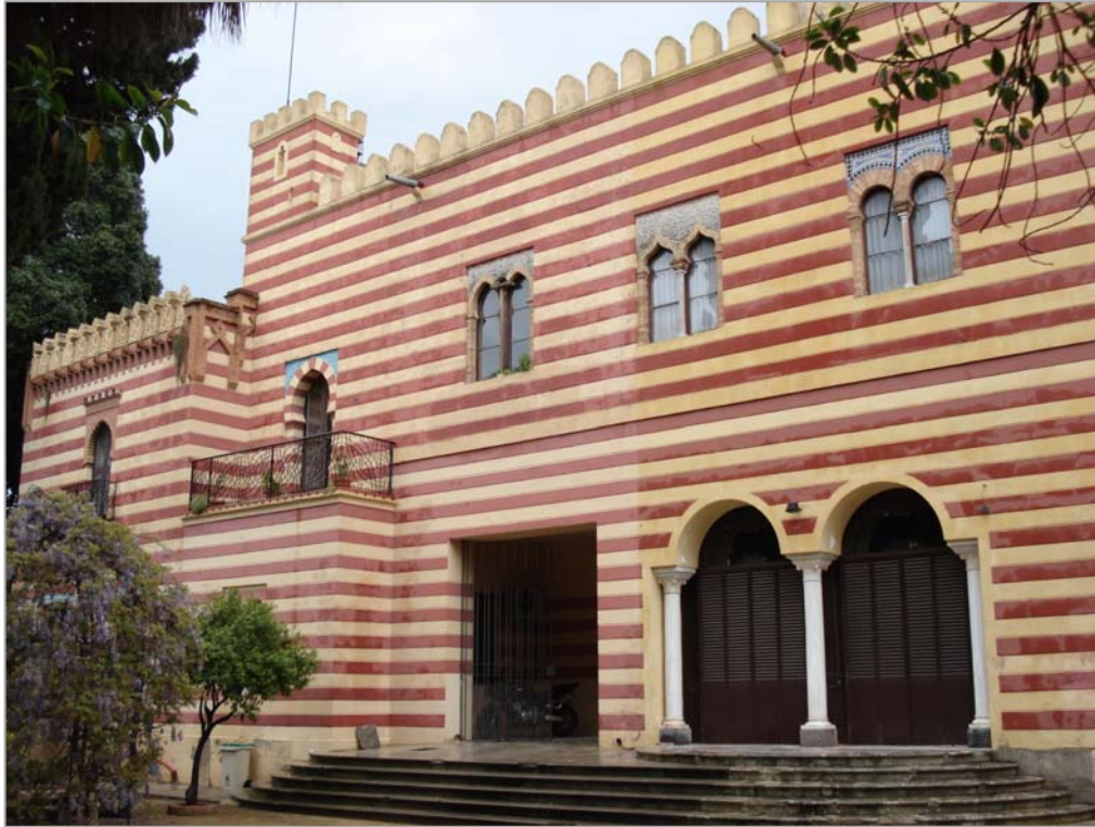
Fragmento parcial de la fachada del jardín o posterior del Palacio Orleans Borbón de Sanlúcar, aspecto actual.
