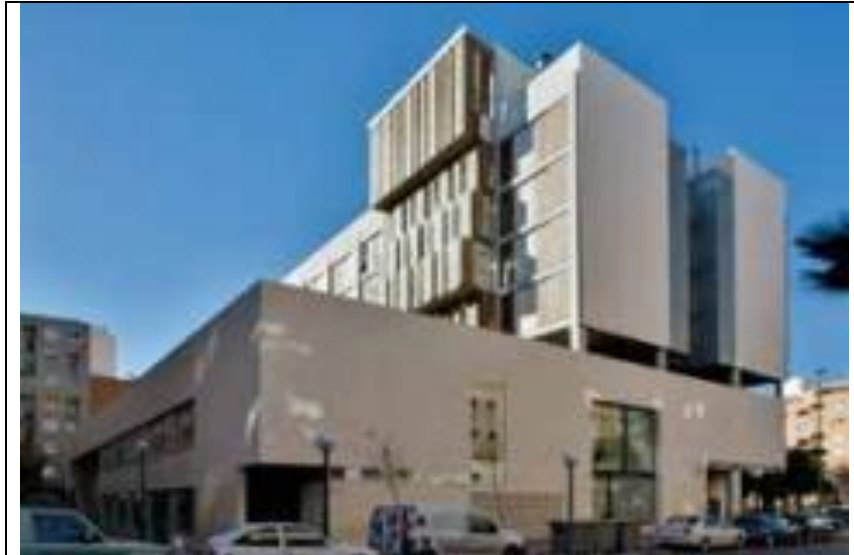
Fig. 1: Edificio Intergeneracional Plaza de América (2010). Alicante.
