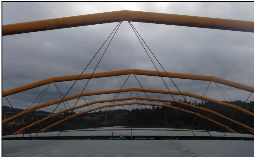
Figura 4. Vista de las péndolas desde la cubierta del nivel superior
