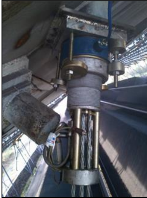
Figura 9. Cabeza activa del anclaje de la péndola
