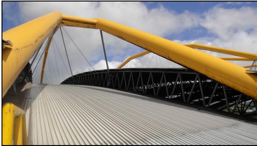
Figura 3. Vista de los arcos y de las cerchas desde la cubierta del nivel inferior
