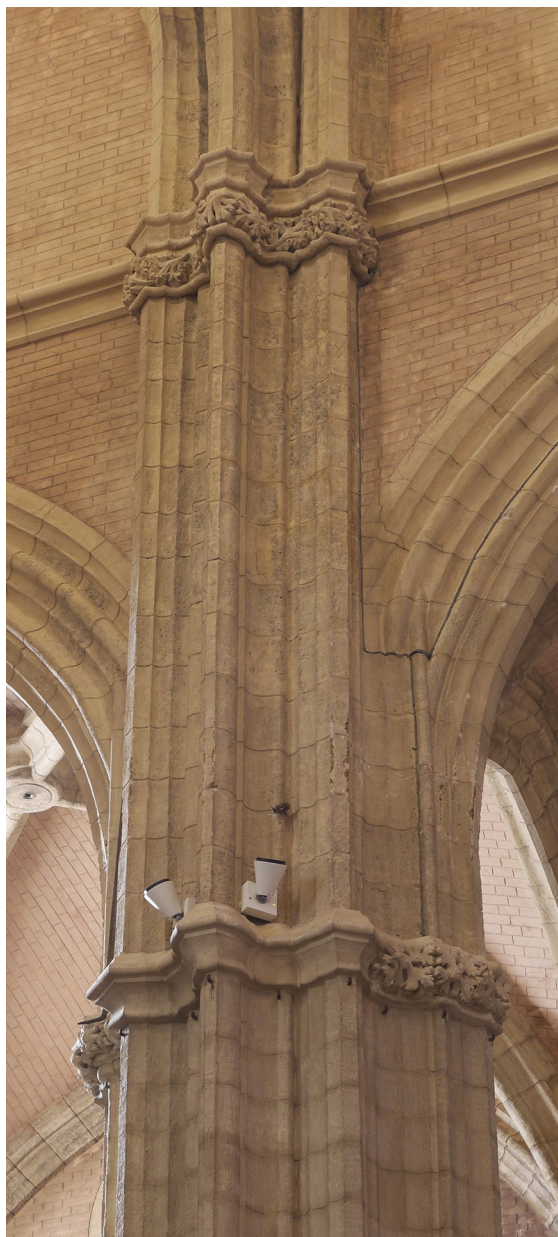
Figura 3. Sta. María de Carmona, 1ª fase, primer y segundo nivel de imposta en los pilares de la nave central (foto de los autores).
