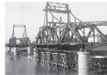
Sobre estas líneas, el puente de hierro o de Alfonso XIII en un momento de su construcción (1925)
