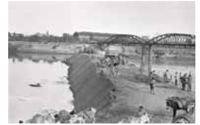
Sobre estas líneas, dique construido para la realización del tapón de Chapina en los años 40-50 del siglo XX Fotografía: Serrano Fototeca Municipal. Sevilla
