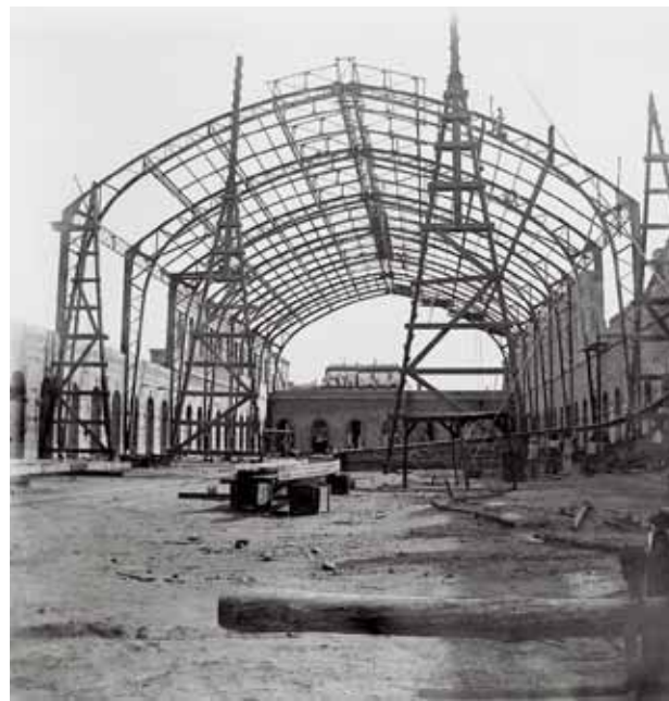
Construcción de la estructura de la nueva estación del ferrocarril Sevilla-Córdoba, construida por la empresa MZA, en terrenos de la antigua plaza de Armas Fotografías: Archivo Caparró [1897] Fototeca Municipal. Sevilla
