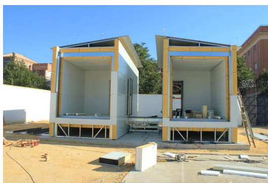
Fig. 51. Módulos de Sevilla en construcción. Fuente: Grupo de investigación TEP-130.
