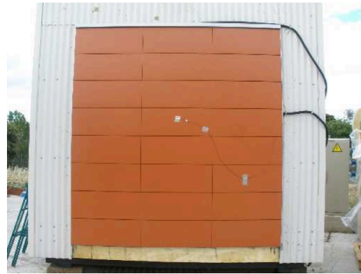
Fig.24. Acabado exterior de los módulos. Fuente: Proyecto REFAVIV.
