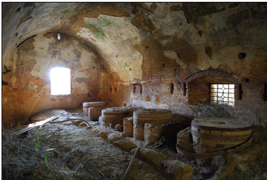
Láms. 53 y 54. Vistas exterior e interior del molino de La Puente, en Niebla (Huelva).
