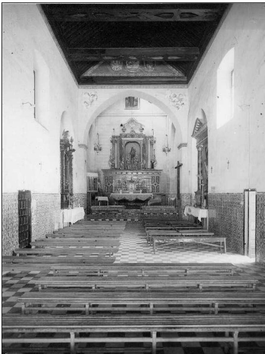
Lám. 74. Interior de la iglesia del Priorato de San Benito de Sevilla en el que se muestra el edificio en 1956. En ese momento, todo respondía a la estética dada durante la reforma impulsada por el Duque de Montpensier en 1851, aunque -desde luego- ya faltaba el retablo con los lienzos de Valdés Leal. (Fot. Laboratorio de Arte, Univ. de Sevilla).
