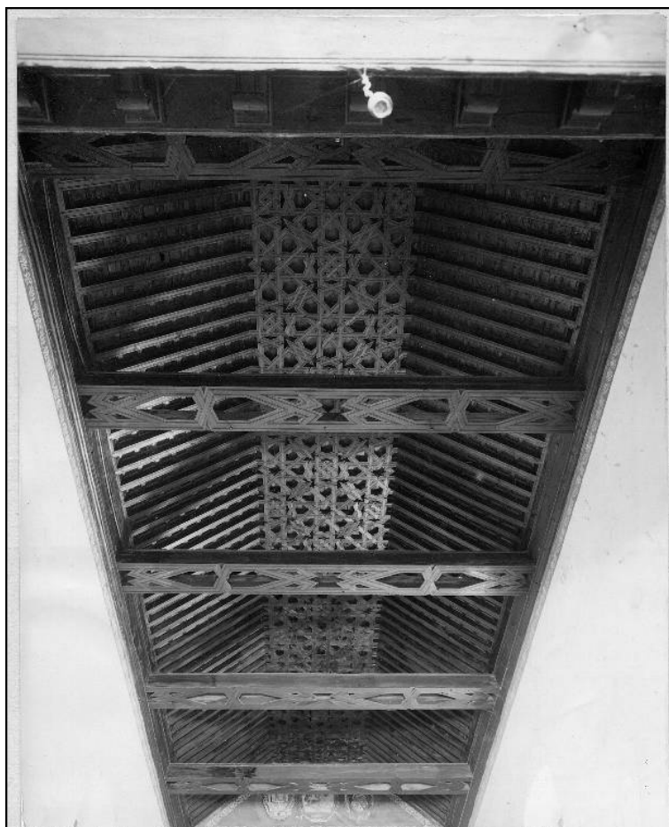
Lám. 63. Artesonado de la iglesia del priorato de San Benito, obra del s. XVII en la que se imitó la antigua cubierta mudéjar (Fot. Laboratorio de Arte, Univ. de Sevilla).
