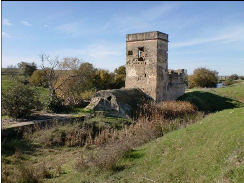
Lám. 33. Molino de Cerrajas, en Alcalá de Guadaíra, restaurado por el comendador frey Juan de las Roelas poco antes de 1459.
