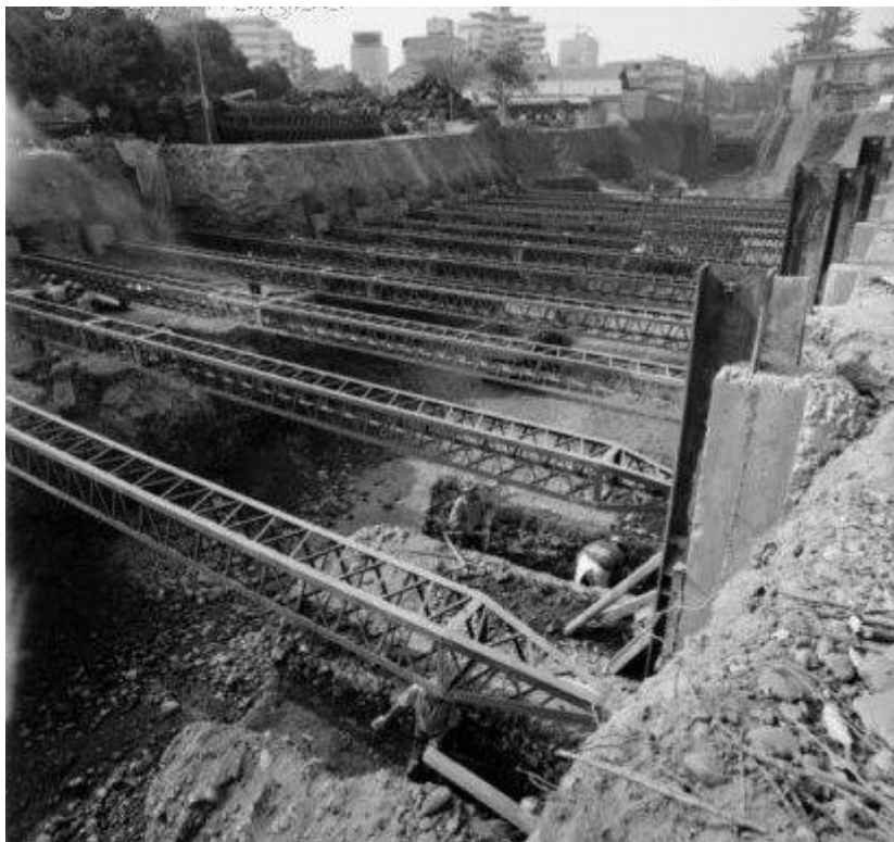
Imagen 31. Trinchera Línea 1 del Metro de Santiago.
