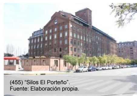
(454) “Silos El Porteño”. Fuente: Elaboración propia.
