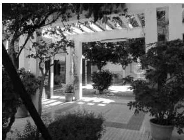
Vista de la pérgola y patio de entrada
