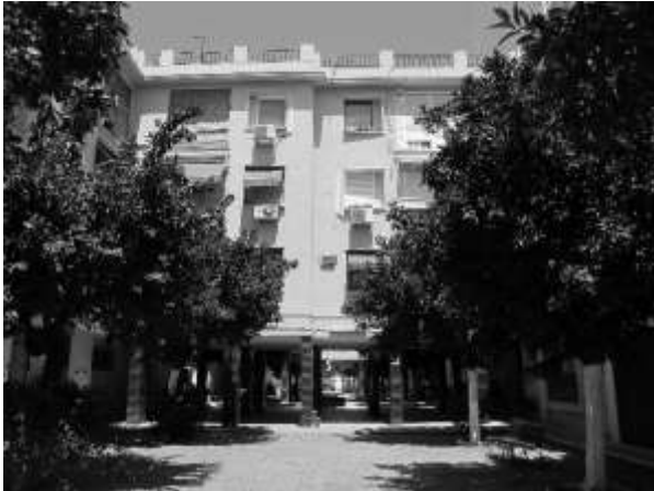
Vista desde el patio lateral del edificio puente
