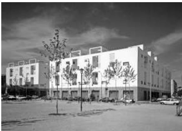
Vista de la manzana-patio desde la calle Blanco White
