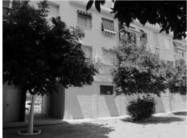
Vista de pasaje que comunica calle Febo con patio interior
