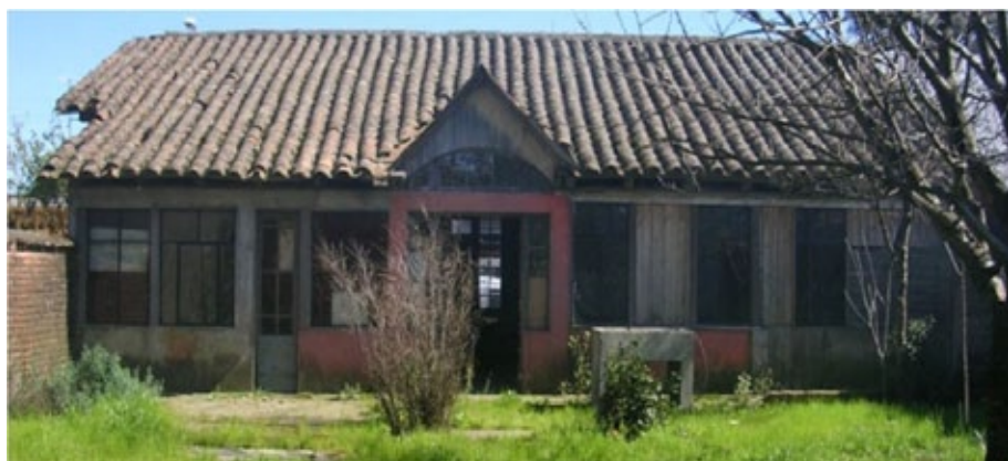
Figura 5. Imagen del jardín interior y fachada trasera de la casa natal de Violeta Parra, “Proyecto A.E.C.I.D A/6265/06 - Comportamiento sísmico de edificios... ”, 2007.
