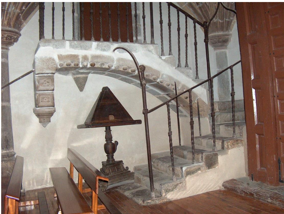
Escalera en el coro bajo
