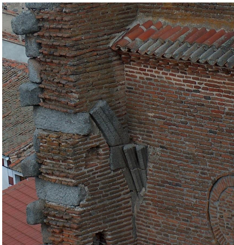
13. Vista exterior del arranque de los nervios de bóveda del primer tramo de la nave del evangelio (el autor 2006)
