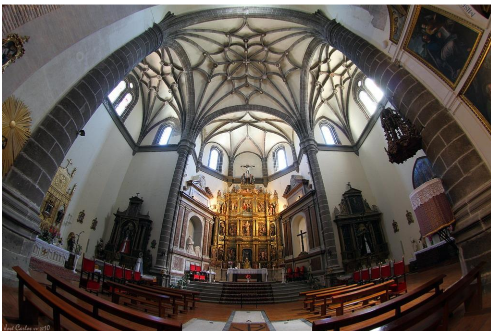
Crucero y ábside
