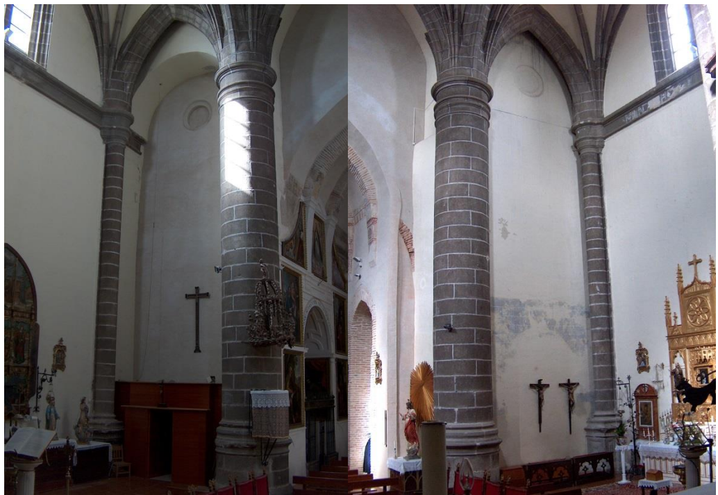
Arranque de la nave de la epístola
