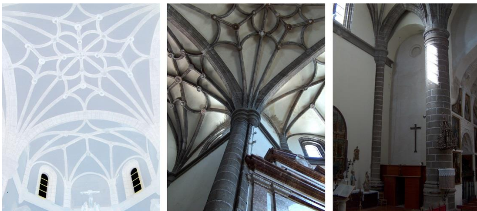
5. Detalles de encuentro de bóvedas del crucero con el ábside y el brazo del evangelio. Línea de imposta recorriendo el interior, fuste liso con basa geométrica. Capitel a la altura de la línea de imposta marcando el arranque de los nervios.
