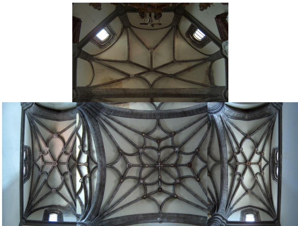
Bóvedas de la cabecera
