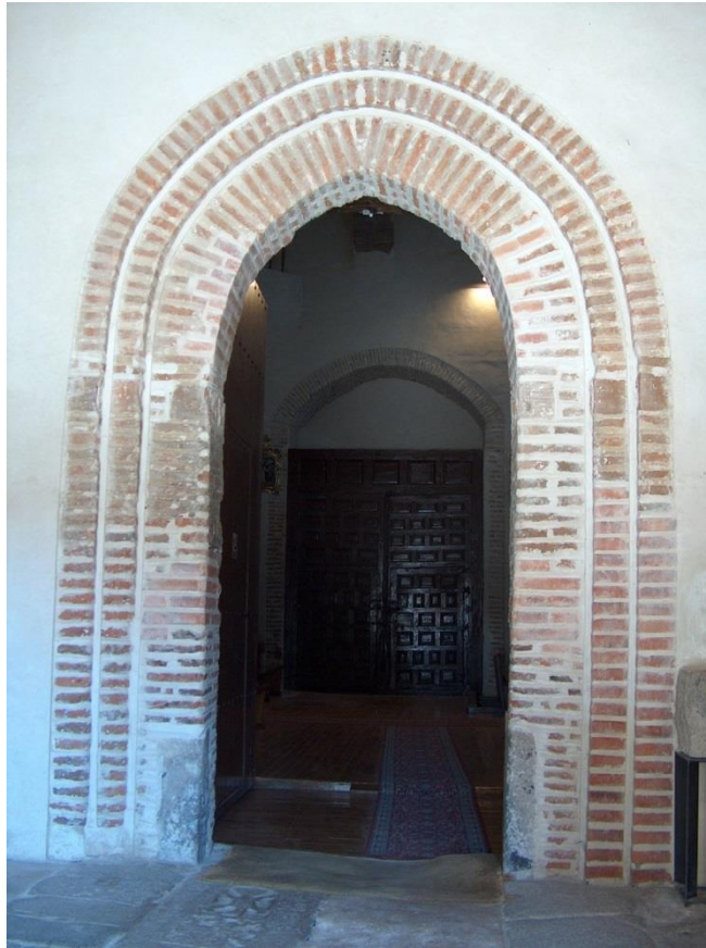
Puerta de acceso a la nave desde el atrio
