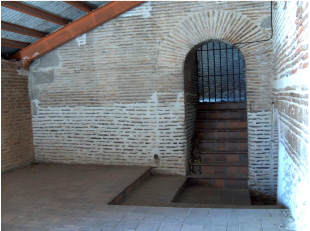
Acceso a la torre desde el atrio alto
