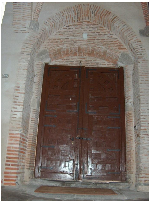
Portada sur desde el interior, acceso al atrio
