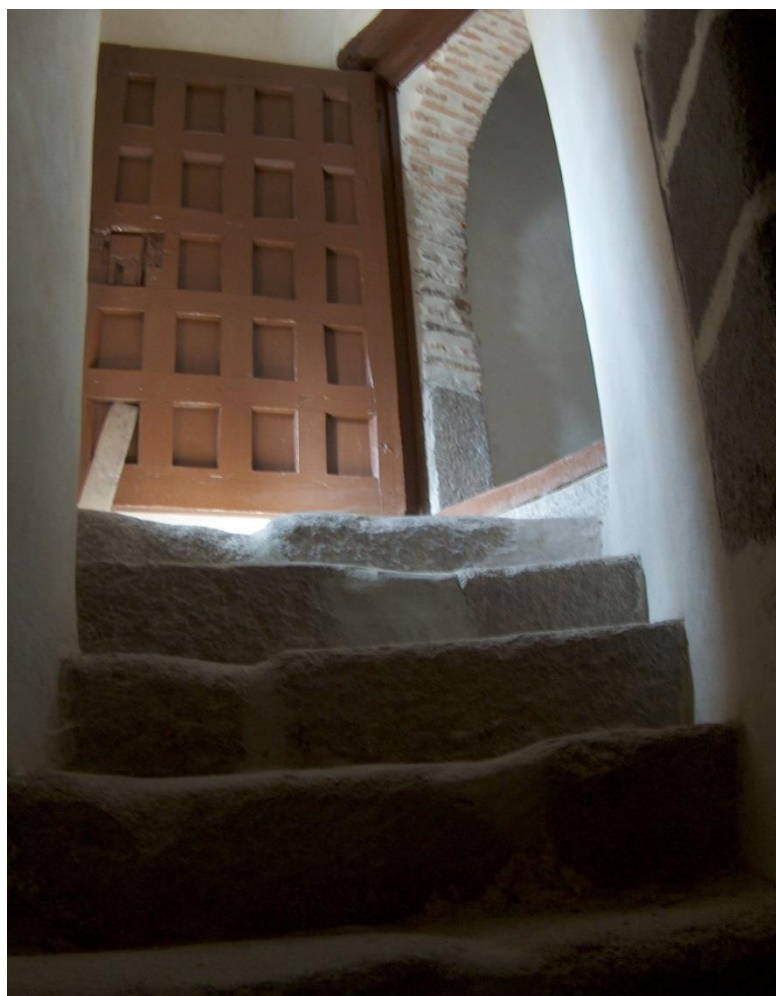
Escalera de acceso al coro alto
