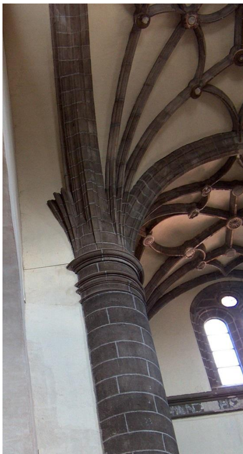
9. Detalle del arranque de los nervios hacia la nave. Columna del crucero (el autor 2006)
