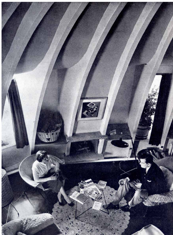
Imagen 1: Francisco Barba Corsini: apartamentos en La Pedrera, Barcelona. Estado original. Fotografía: Revista Nacional de Arquitectura , n.º 166 (1955).
