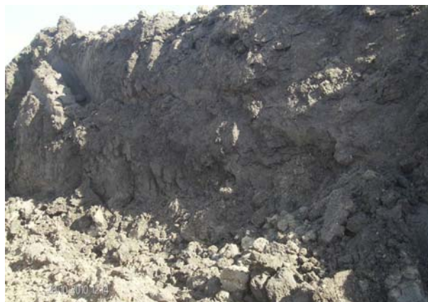
Figura 4-9: Detalle de afloramiento de arcillas negras de fondo de vaguada. Presenta cuarteado por desecación lo que indica su alta plasticidad.
