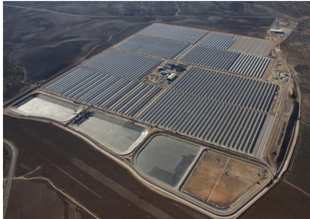
Figura 4-1. Fotografía aérea de la obra de la que provienen las muestras objeto de la investigación
