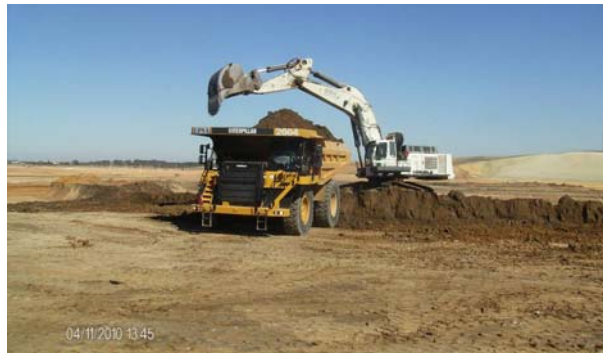
Figura 4-8: Excavación del afloramiento de arcillas negras de fondo de vaguada
