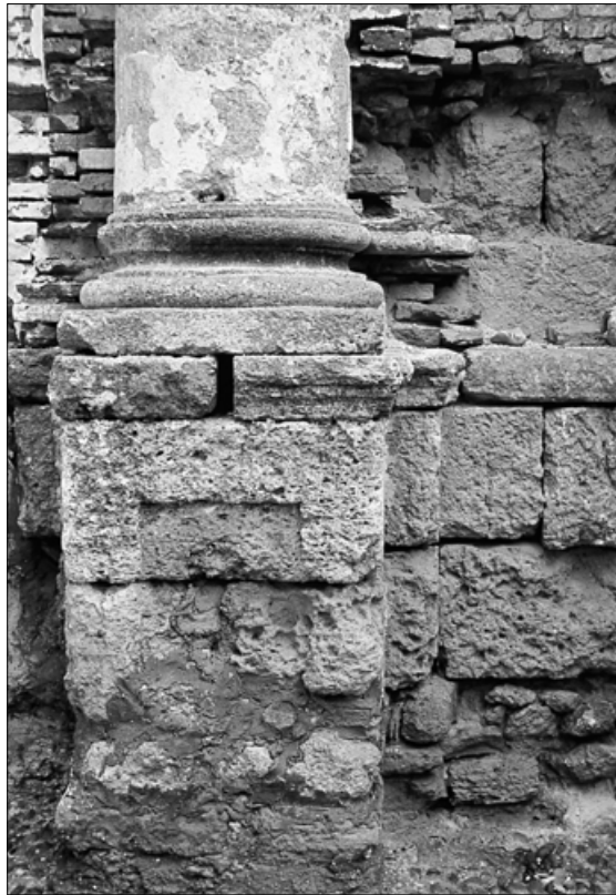
Fig.1 Aspecto del alto grado de alteración de la piedra y reparacheos de intervenciones recientes
