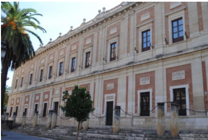
Figura 1. Fachada norte de la lonja de mercaderes, actual AGI (Sevilla). 1583-1604.
