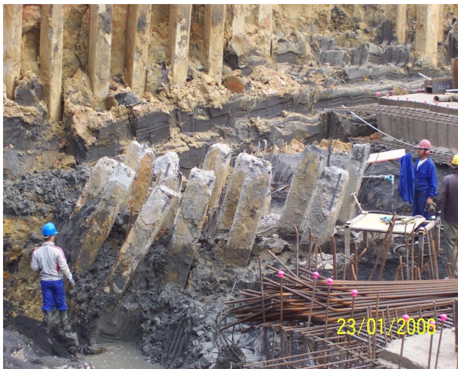
Ilustración 52. Pilotes de hinca en la cimentación del mercado de la Pescadería (Huelva). Fuente: Archivos del estudio de D. Joaquín Aramburu Maqua.
