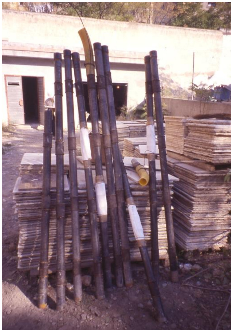
Ilustración 87. Manguitos en obra con el dispositivo fusible.
