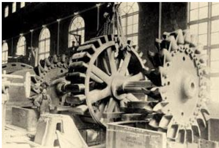
Ilustración 16. Rueda tipo Peltón sistema hidráulico para el suministro de energía. (1904). http://tregaby.blogspot.com.es/p/la-asland-i-el-clot-del-moro
