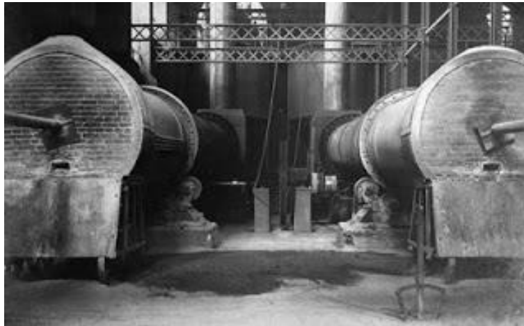
Ilustración 15. Hornos rotatorios en la fábrica Asland. (1904). http://tregaby.blogspot.com.es/p/la-asland-i-el-clot-del-moro
