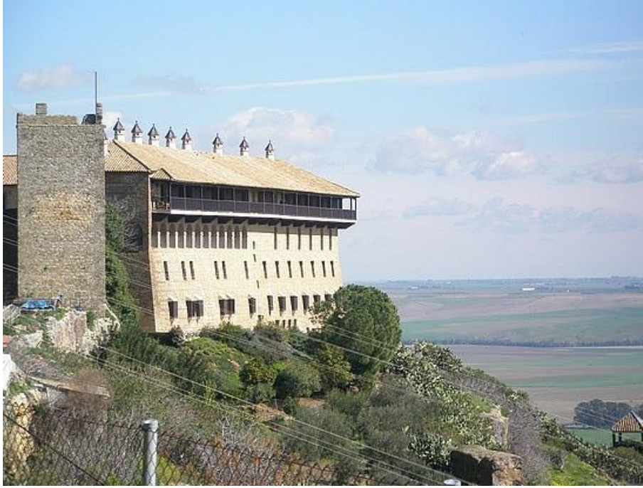
Ilustración 102. Emplazamiento del edificio al borde de la cornisa.
