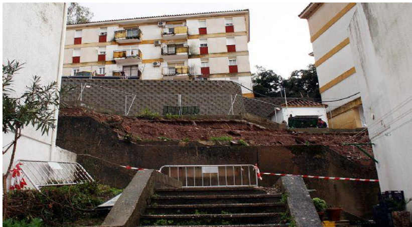
Ilustración 69. Deslizamientos en la barriada de El Lario (2009). http://andaluciainformacion.es/barbate/166943/las-obras-de-rehabilitacin-de-el-lario-a-buen-ritmo/
