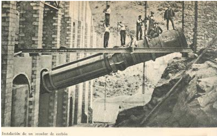
Instalación de un secador de carbón.
