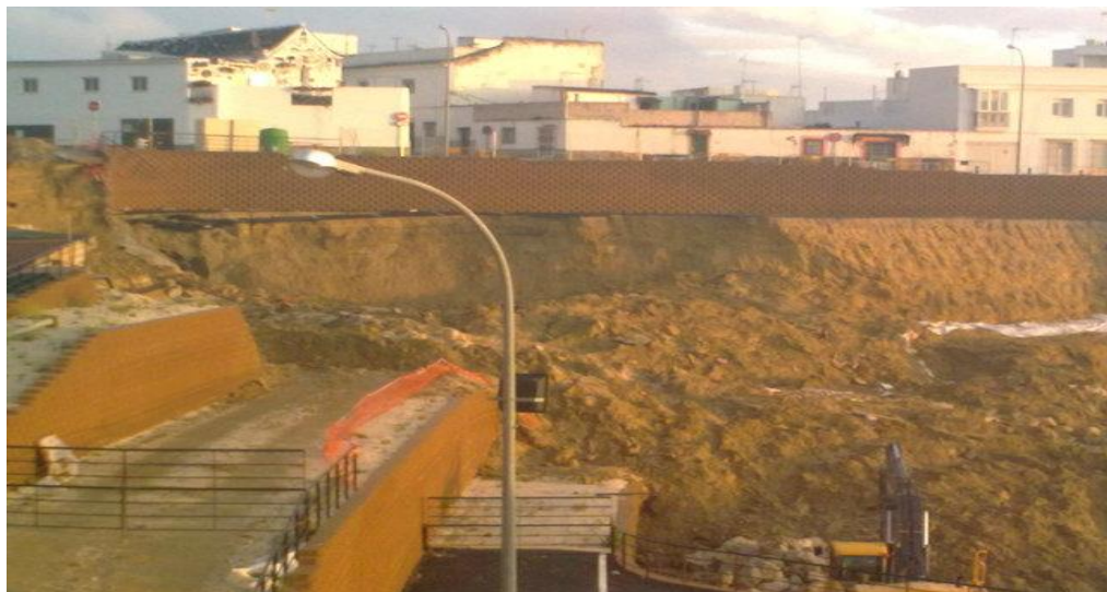
Ilustración 65. Corrimientos en Medina Sidonia (2010) con terrenos de relleno de aluvión (II). http://miciudad.lavozdigital.es/arcos/buscar?tag=Medina
