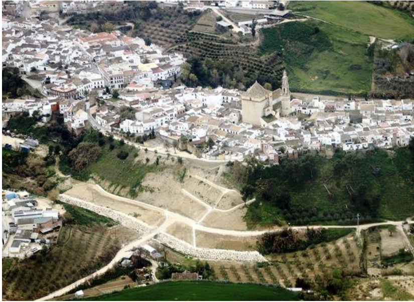
Ilustración 73. Obras de estabilización de talud en Santaella finalizadas en 2013. http://www.santaella.es/noticias?noticia=69&return_id=19&plantilladetalle=Detalle%20Noticia%20con%20Categorias
