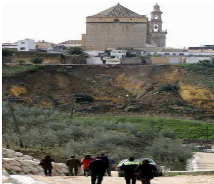
Ilustración 72. Desprendimientos en Santaella (Córdoba, 2010). http://www.elmundo.es/elmundo/2010/03/10/andalucia/1268244812.html
