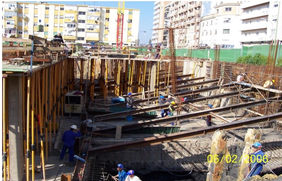
Ilustración 100. Complejidad de ejecución de la obra. Entibación y losa.
