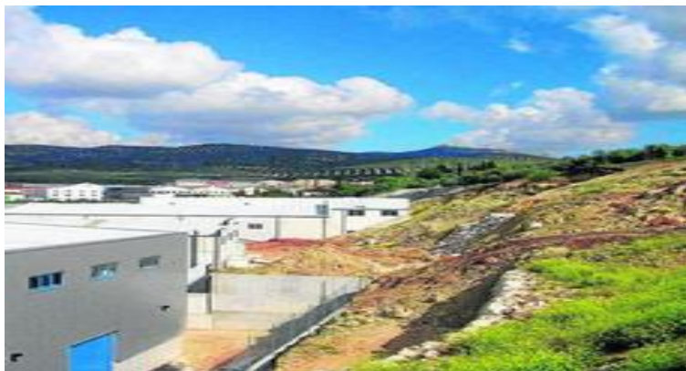
Ilustración 74. Deslizamientos en el Parque Industrial de Lucena (Córdoba, 2010). http://sevilla.abc.es/hemeroteca/historico-31-03-2009/sevilla/Cordoba/lucena-un-corrimento-de-tierra-afecta-a-seis-empresas-en-el-parque-principe-felipe_
