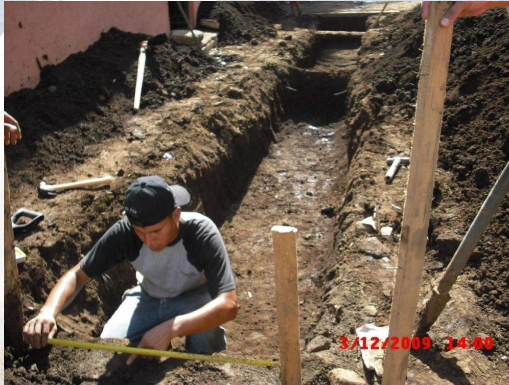
Construcción de zanja
