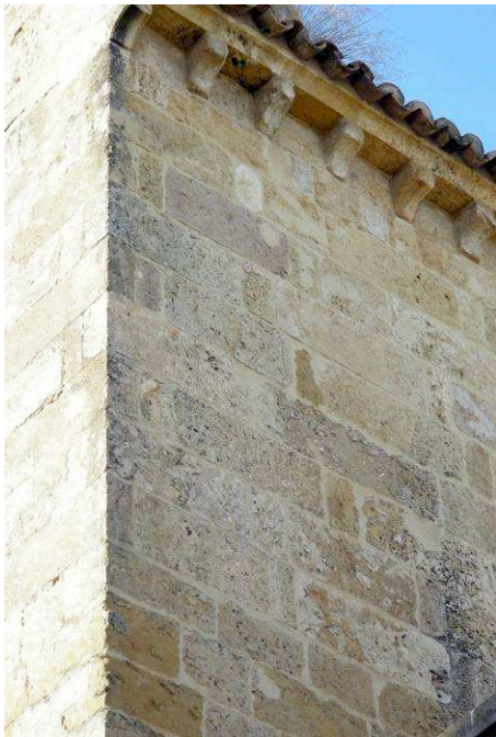
Fig. 7. Aparejo de muro a soga y tizón
