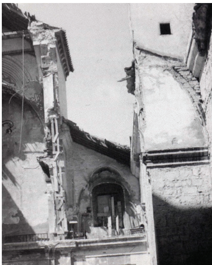
Fig. 6. Derrumbe de Santiago, en 1981. Véase el coro alto de los pies, el antiguo alminar (dcha.), los restos de bóvedas de arista y la redefinición formal del rosetón gótico y la del óculo lateral (Archivo Junta de Andalucía).
