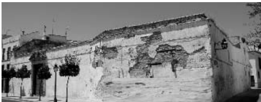
Figura 6. Restos actuales de la iglesia de San Nicolás de la Ajerquía, vista desde el sureste
