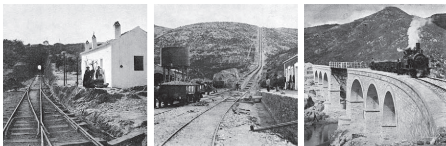
FIG 2. La línea de ferrocarril a principios de siglo XX: Túnel y apeadero de los Membrillos; plano inclinado; puente sobre el río Odiel.
