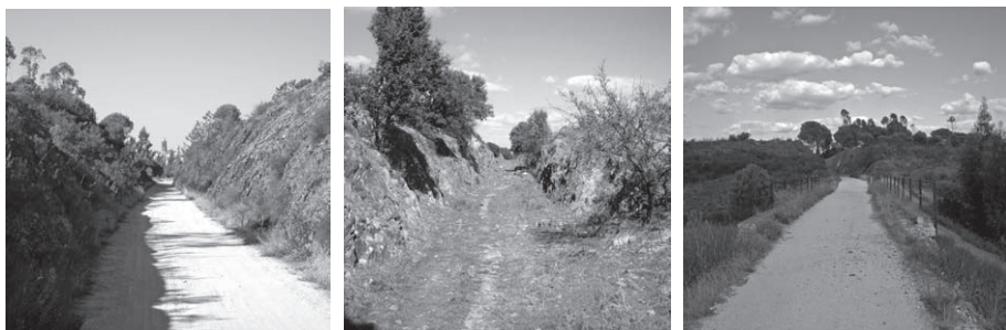
FIG 11: Trincheras excavadas en el terreno para aplanar la plataforma por la que circulaba el ferrocarril.
