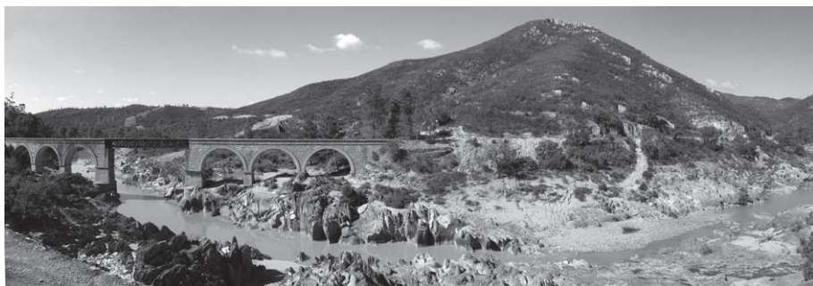
FIG 12: Puente de la línea Empalme-Mina Concepción sobre el río Odiel.
