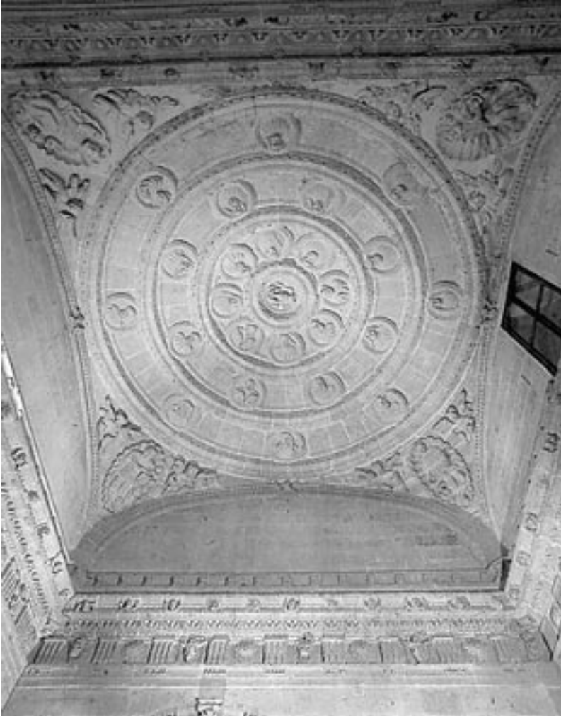
Lámina 13. Iglesia de Santa María. Arcos de la Frontera (Cádiz). Bóveda de la sacristía.
