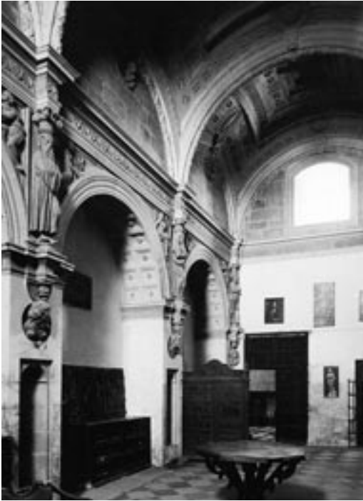
Lámina 4. Iglesia del Salvador. Úbeda (Jaén). Interior de la sacristía.
