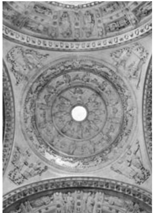
Lámina 11. Catedral de Sevilla. Bóveda de la Sacristía Mayor.
