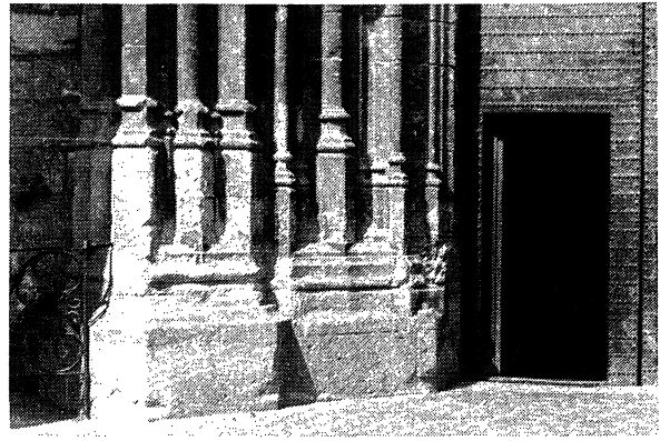
b) Alveolizaciones en zócalos. b) Alveolar erosion on socles.
