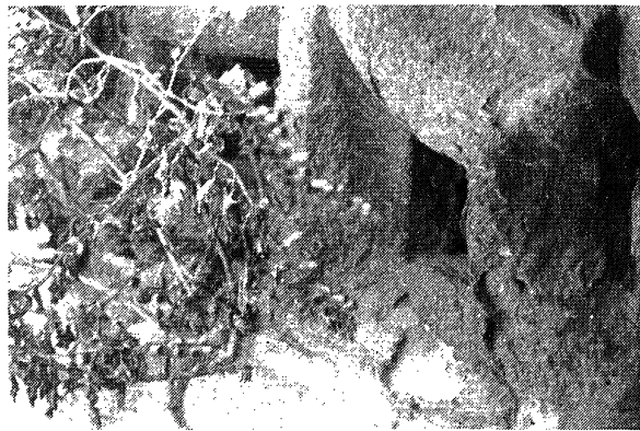
c) Disyunciones de placas. c) Contour scaling.
