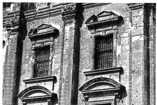
f) Arenizaciones diferenciales, más graves en los dinteles.
