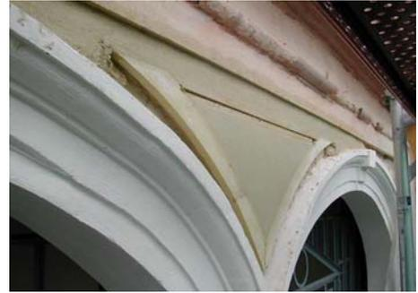
Figura 23. Reglas curvas de madera empleadas para la elaboración de las molduras de los triángulos curvos centrados en las enjutas de los arcos.
