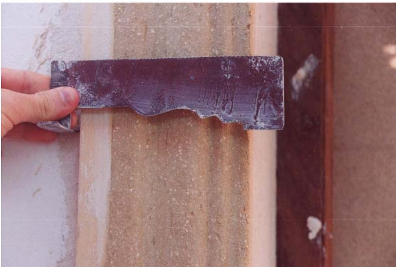
Figura 14. Plantilla de las terrajas de las ventanas de la fachada manierista, realizada con chapa de hierro de 3 mm.
