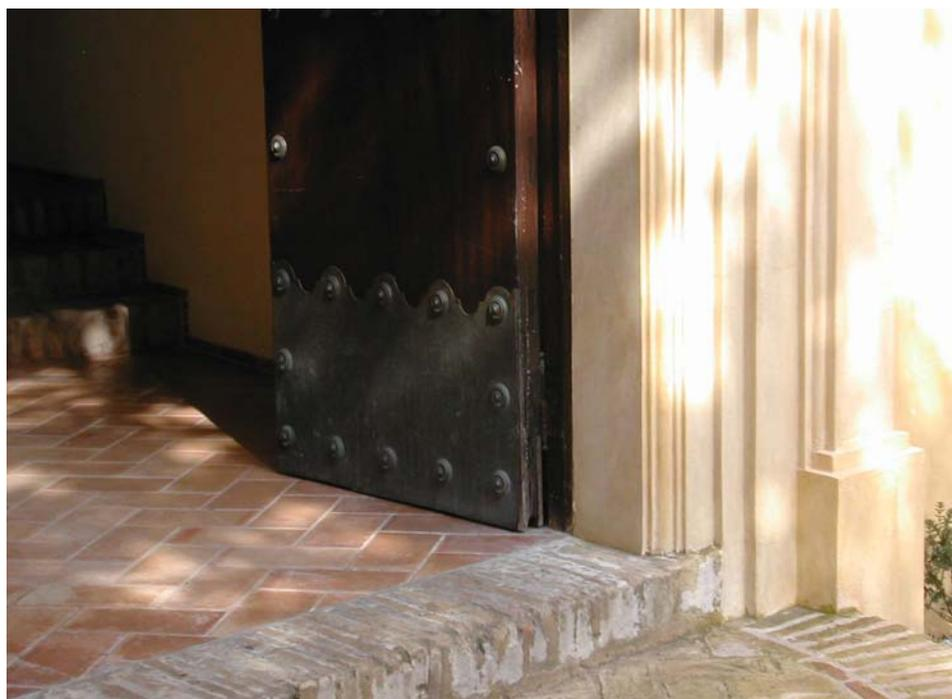
*Figura 28. Detalle de la parte inferior del marco de la portada terrajada y estucada de la fachada norte.*
