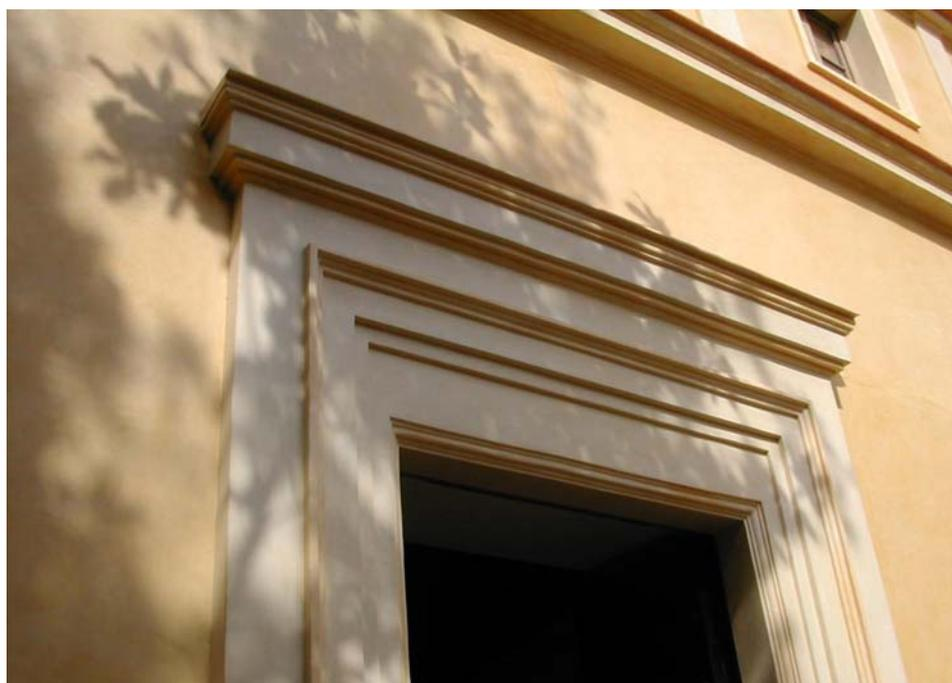
*Figura 29. Detalle de la parte superior de la portada terrajada y estucada de la fachada norte.*
