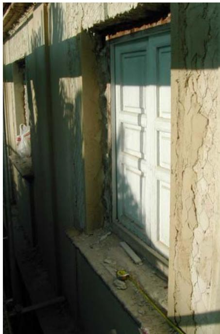
Figura 12. Incorporación en el revestimiento de una malla metálica para incrementar la adherencia, evitar fisuras horizontales de descuelgue y ligeramente armarlo.
