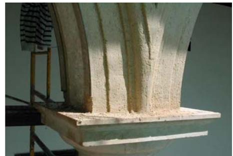
Figura 24. Revestimiento con mortero de cal y terrajado en el arranque de la molduración de las roscas de los arcos.
