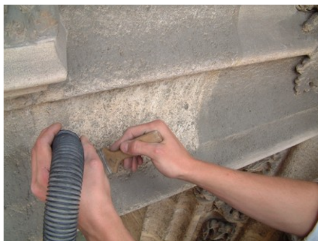
Foto 5. Retirada mediante aspiración de la capa de polvo que recubría las superficies en la portada del Bautismo. Año 2004
