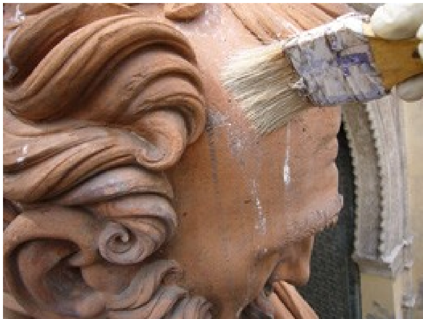
Foto 6- Limpieza de depósitos de guano en la figura de San Pedro de la Puerta del Perdón. Año 2009
