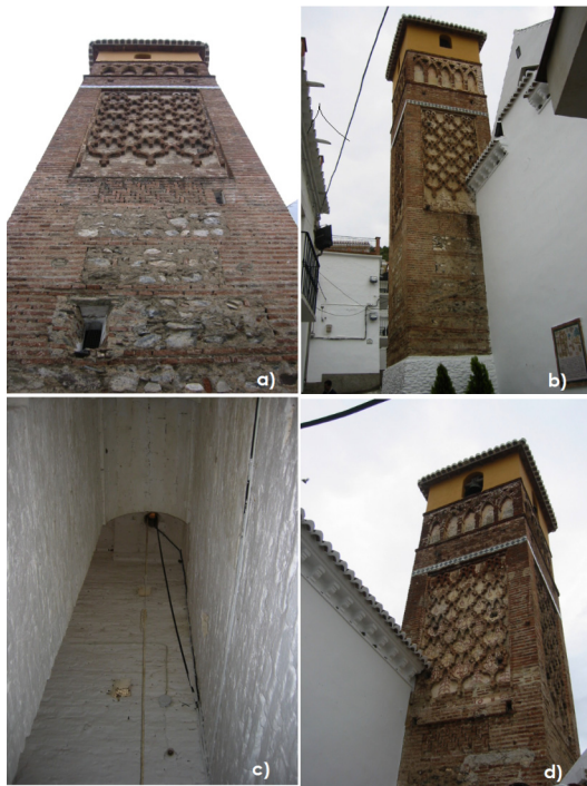
Fig. (1). (a), (b), (d) general views; (c) inside chamber.
