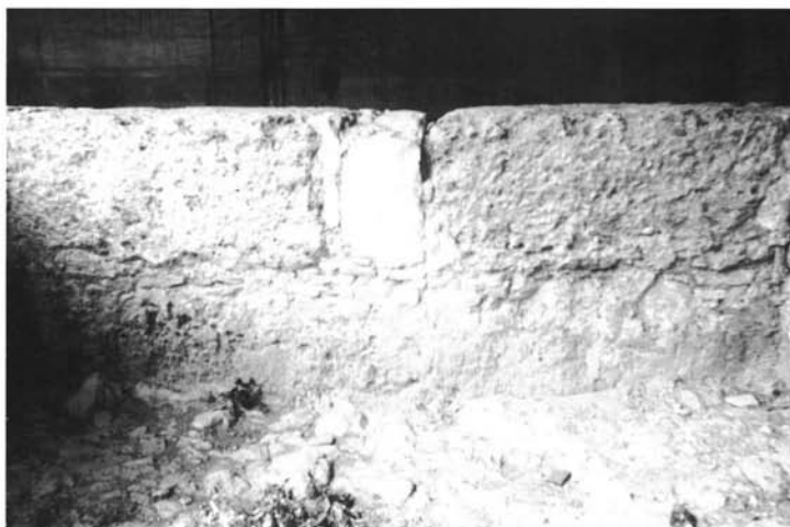
Lám. 1.- Detalle constructivo de los paramentos de la iglesia (Foto E.T.C.)
