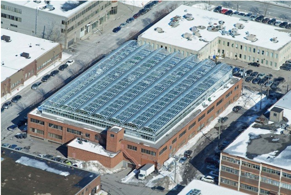
Le premier complexe de serres des Fermes Lufa
